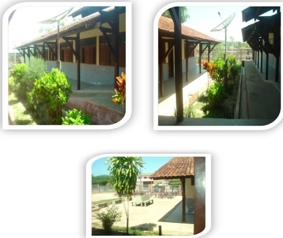
Figuras 2, 3 e 4 – Corredores da escola. Área externa, próximo a quadra de esportes Fonte: Pesquisa de campo realizada em maio/2009 Foto: Luciana Rodrigues, em 15/05/09.
