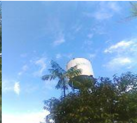
Foto 02: Caixa de Armazenamento de Água Fonte: Janilma Vilhena (2009)
