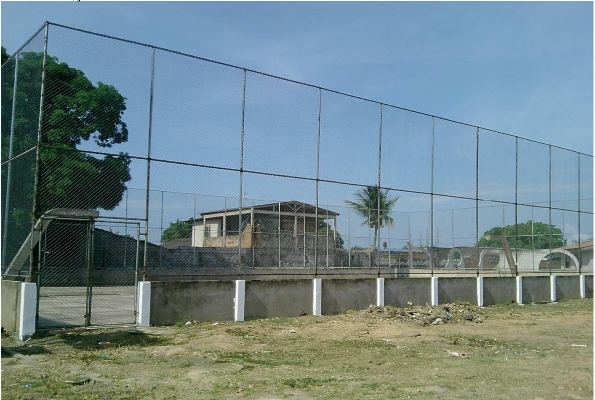
Foto 11 - Praça do bairro Jesus de Nazaré em reforma .
