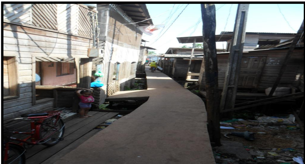
Figura 20: Passarela de concreto na Baixada do Ambrosio.
