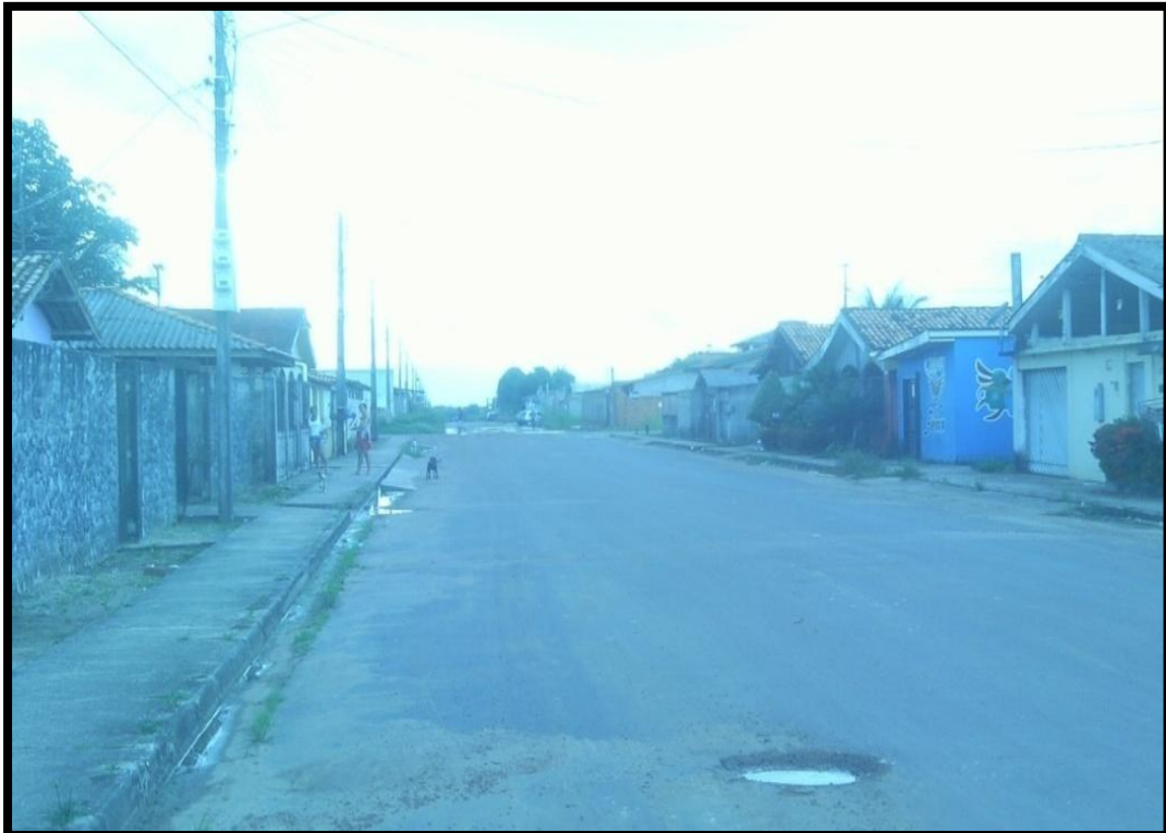
Figura 3: Conjunto habitacional do Infraero II, já modificado.
