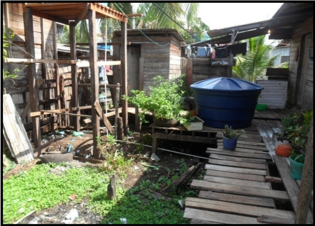
Figura 23: Ausência de fossa asséptica na Baixada do Ambrósio.
