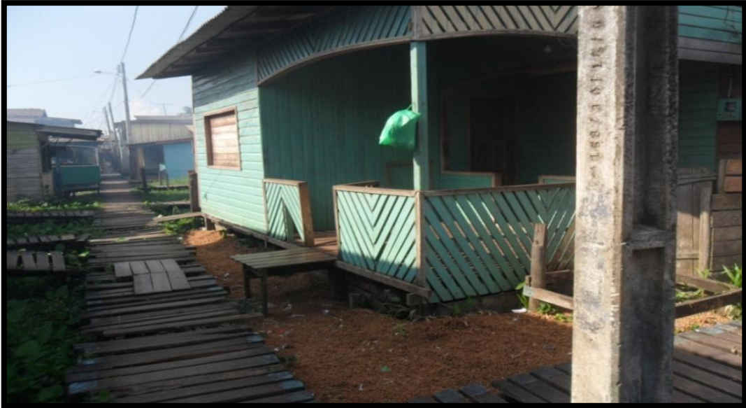
Figura 19: Aterramento da área com caroço de açaí e resíduos orgânicos.
