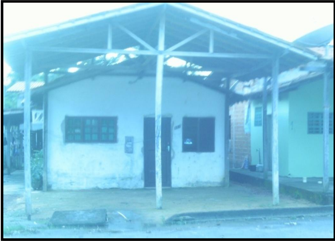
Figura 6: Padrão das casas do conjunto habitacional do bairro das Pedrinhas.
