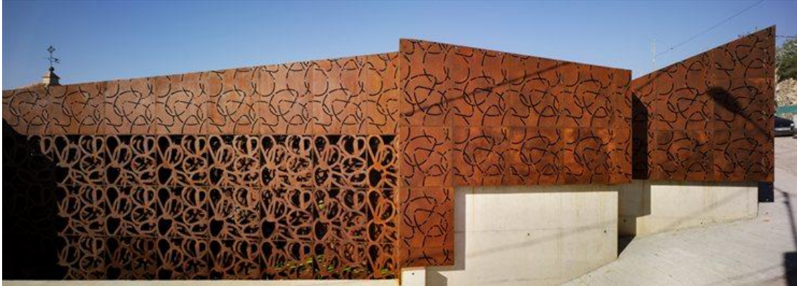
Figura 58: Fachada revestida de aço corten recortado a laser.
