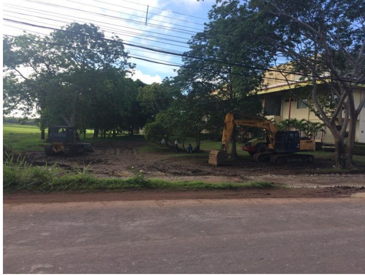
Figura 43: Aterramento da ressaca Lagoa dos Índios. Fonte: A autora
