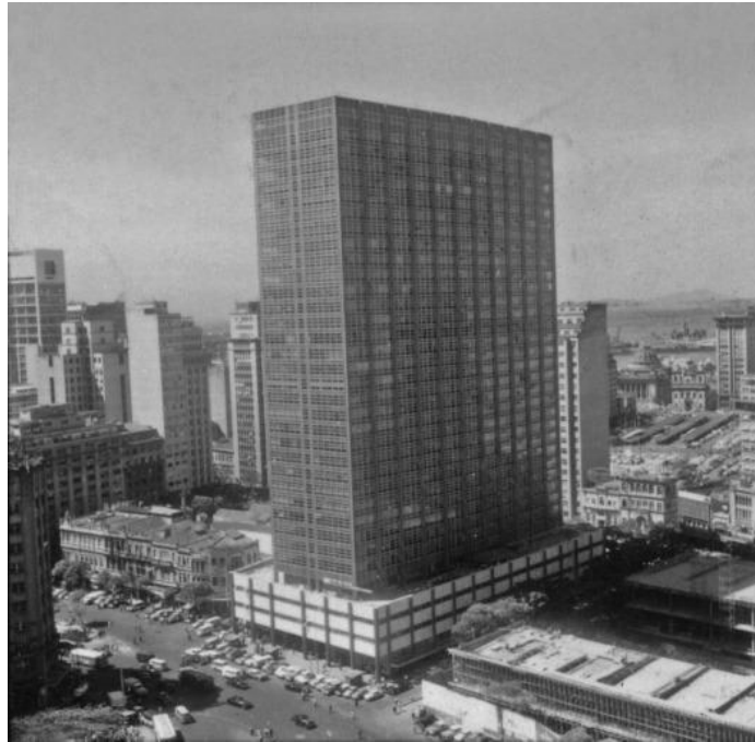
Figura 13 - Edifício Avenida Central
