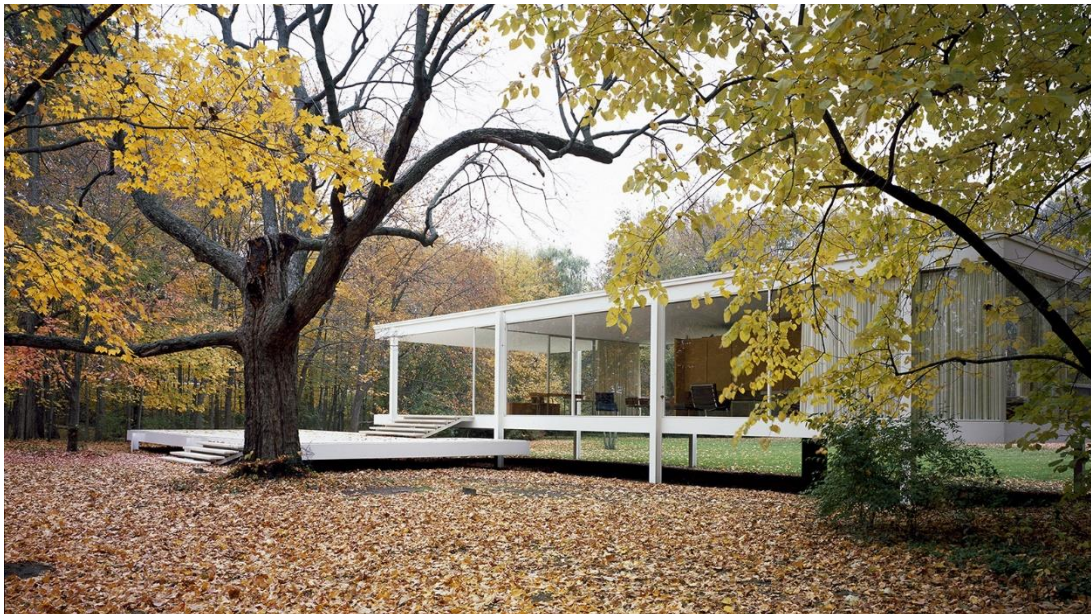
Figura 7 - Casa Farnsworth de Mies van der Rohe
