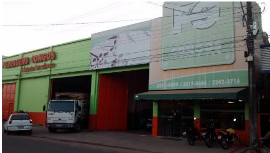
Figura 53 - Fachada Ferragens Congós
