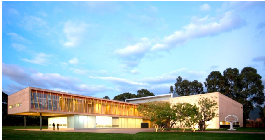
Figura 58 – Interação com o entorno e disposição volumétrica da Escola Los Nogales
