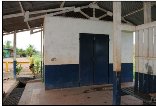
Figura 31 Bloco de banheiros Fonte: Acervo Pessoal
