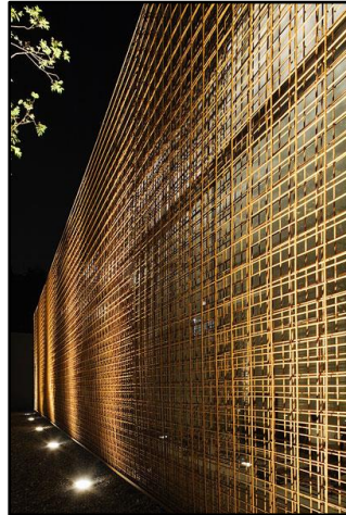
Figura 75 Fachada em aço corten Fonte: Site Constructalia
