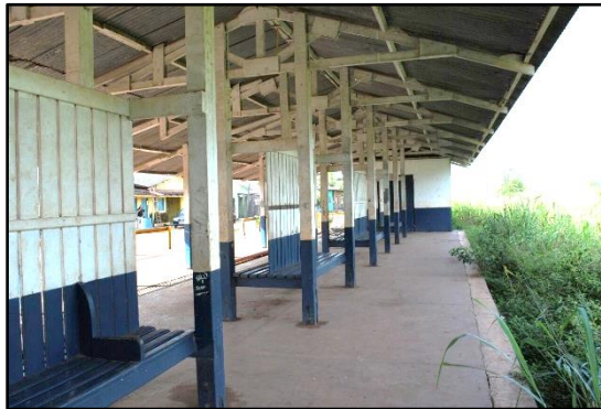
Figura 29 Interior da estação de trem Fonte: Acervo Pessoal
