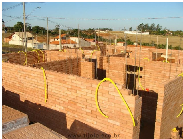
Fig. 06 – paredes feitas com tijolo ecológico
