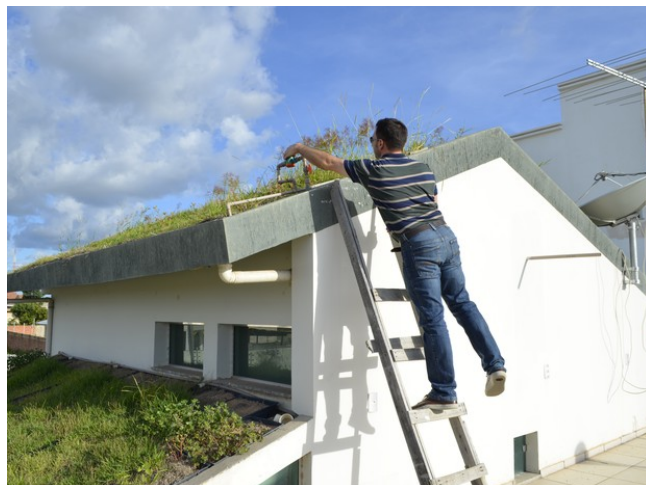
Fig. 30: imagem mostra casa sustentável em Roraima e seu telhado verde Fonte: http://www.promosa.com.br
