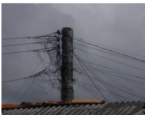
Figuras 87 – Aglomerados na fiação pública em função de ligações clandestinas
