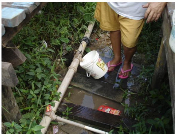
Figura 83 – Forma captação de água por alguns moradores
