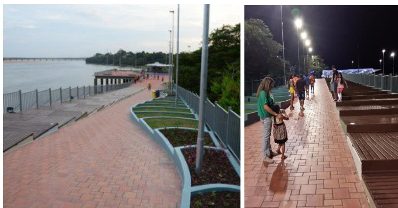
Figuras 56 e 57 - Vista Orla Taumanan, área de lazer na cidade de Boa Vista
