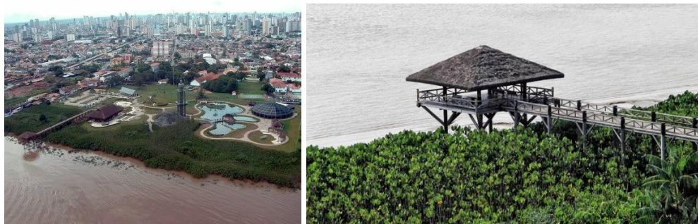
Figura 47 e 48 – Água como elemento de conexão entre o ambiente natural e o ambiente projetado.
