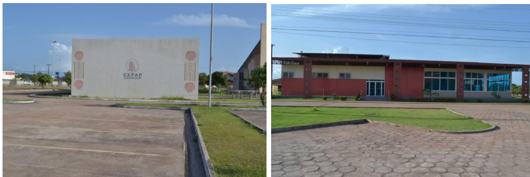
Figura 128 e Figura 129 – Piso em concreto comum cimentado e em blocos de concreto sextavado.
