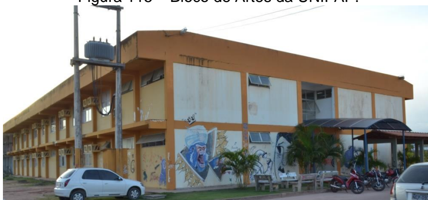
Figura 115 – Bloco de Artes da UNIFAP.
