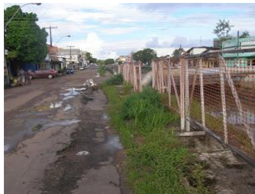
Figura 6 - Obra de revitalização no governo Waldez Góes /2010.
