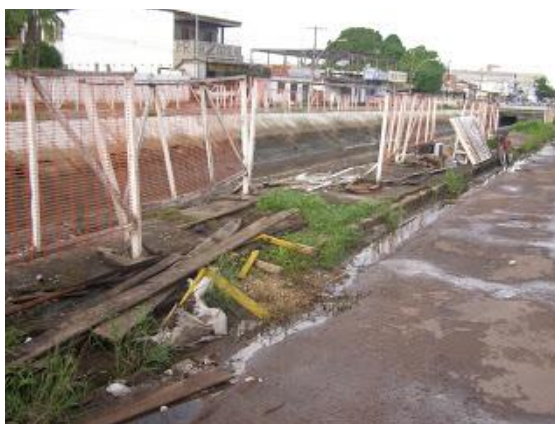
Figura 4 - Obra de revitalização no governo Waldez Góes /2010.
