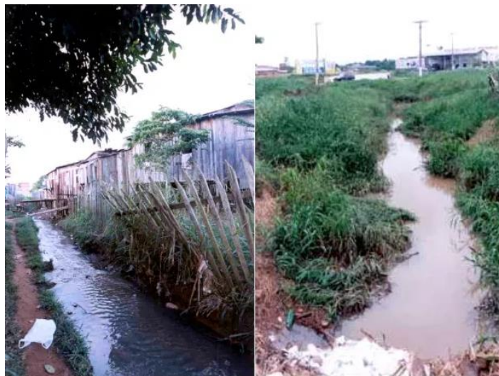
Figura 44 - Área do Parque da Maternidade antes da intervenção – Acre/2017.
