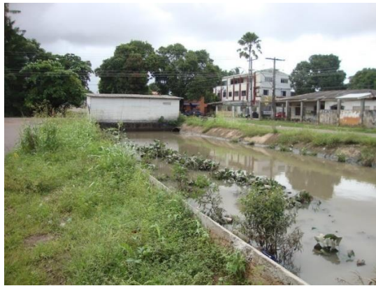
Figura 5 - Obra de revitalização no governo Waldez Góes /2010.
