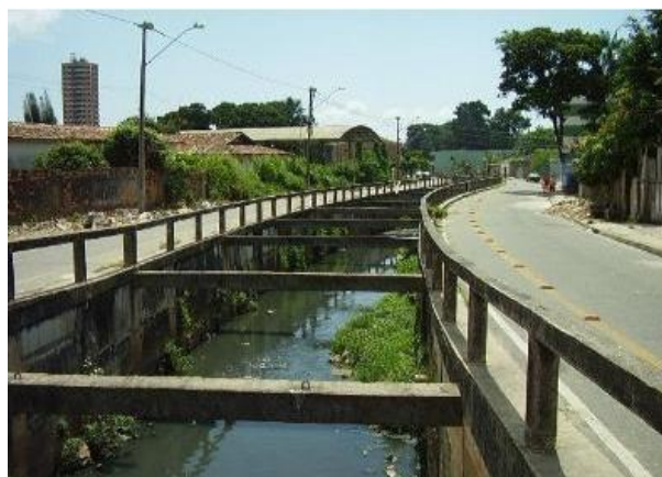
Figura 45 - Solução convencional em drenagem urbana, Avenida de fundo de vale Canal Água Cristal, Belém-Pa.
