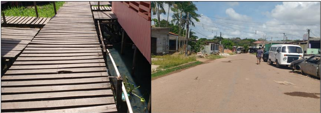
Figura 29 - Passarelas (à esquerda, figura A) e vias em terra firme (à direita, figura B).
