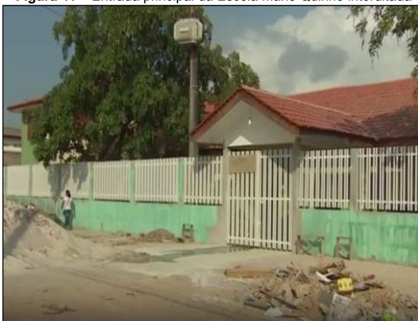
Figura 41 – Entrada principal da Escola Mário Quirino interditada
