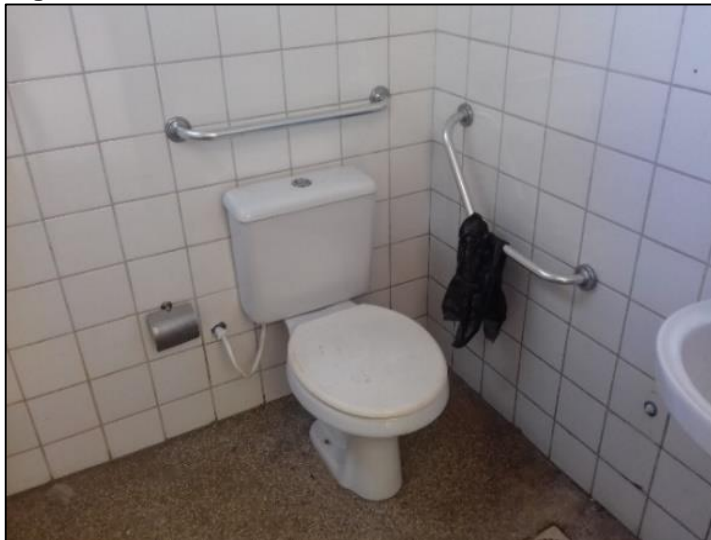
Figura 51 – Sanitário acessível da Escola Nanci Nina Costa
