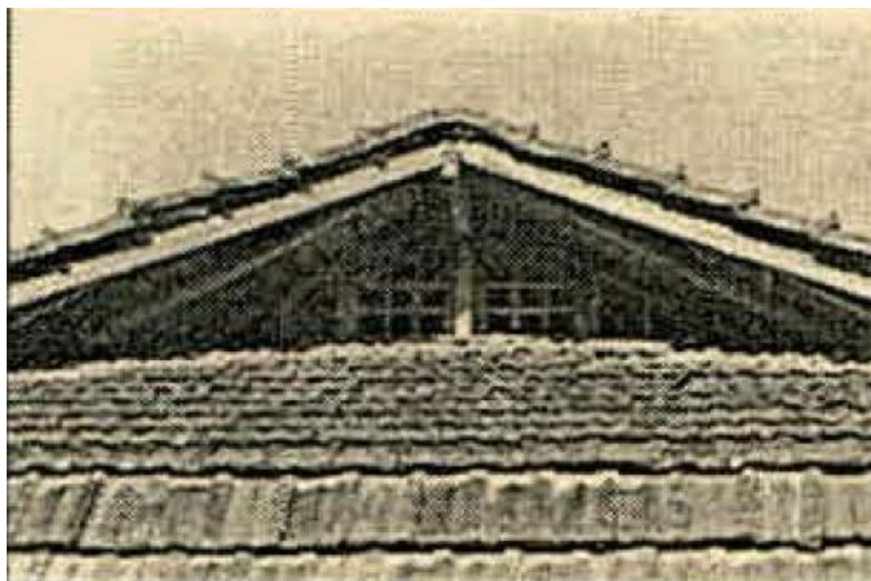
Figura 46 - Cobertura com ático ventilado da residência “Onda Amarela”, em Belém, 1966.
