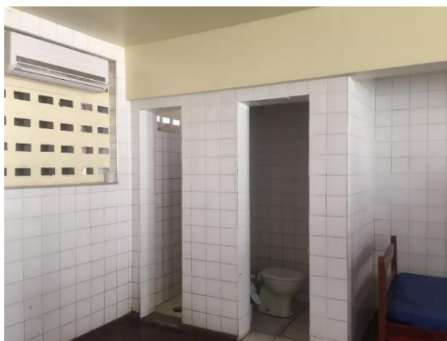
Figura 28 - Banheiros da Enfermaria Masculina.
