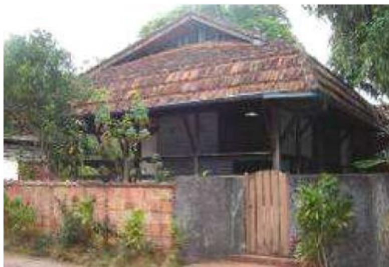
Figura 45 - Beiral “quebra-sol/quebra-chuva” da residência “Onda Amarela”, em Belém, 1966.
