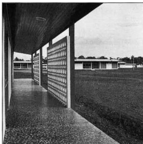
Figura 36 - Beirais largos e painéis de elementos vazados protegem os corredores externos das intempéries naturais.
