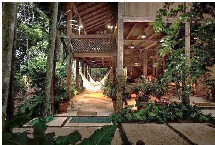
Figura 43 - Vista Externa da Residência: residência de Robert Schuster.
