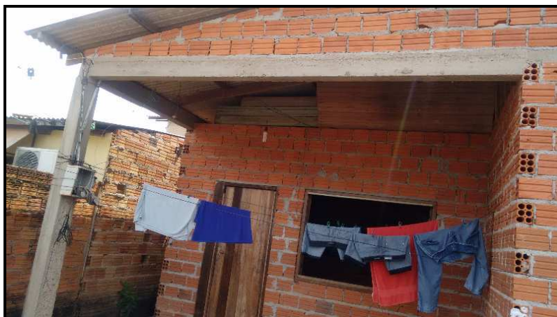
Figura 28 – Casa em fase de acabamento.
