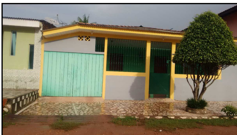
Figura 19– Garagem improvisada, dificuldade de uso.
