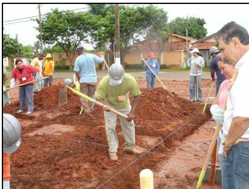
Figura 5 - Assistência Técnica em sistema de mutirão
