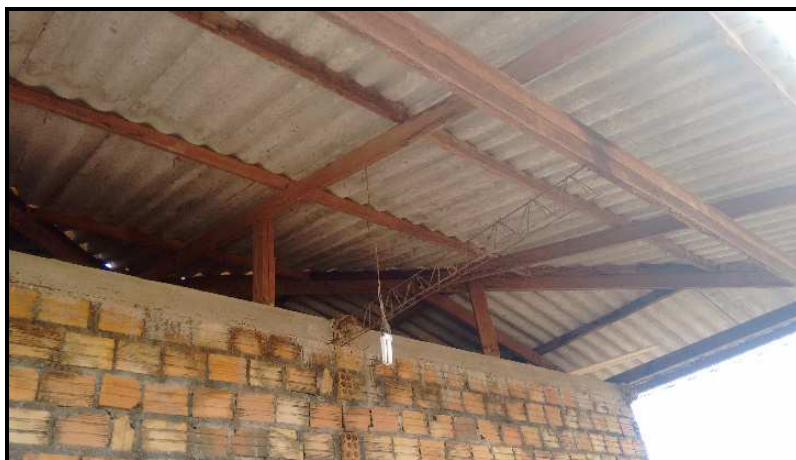
Figura 24 – Espera na cinta de amarração (ampliação)
