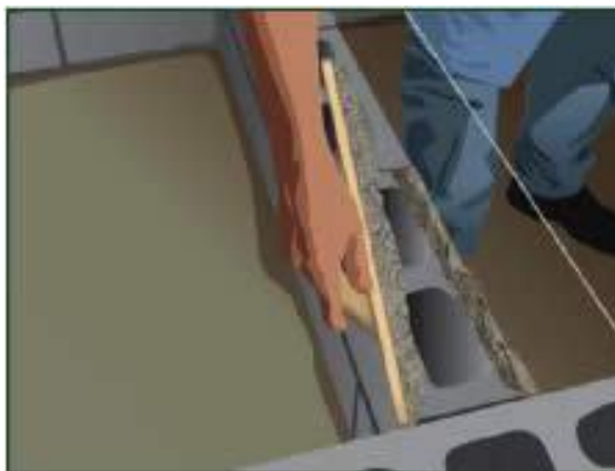
Figura 26 - Aplicação da argamassa nas paredes longitudinais. Fonte ABCP.
