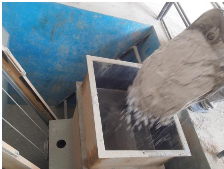
Figura 15 - Colocação dos agregados. Fonte: Manual de produção de bloco da empresa Comblocos. Gabriela Lustosa (2016).
