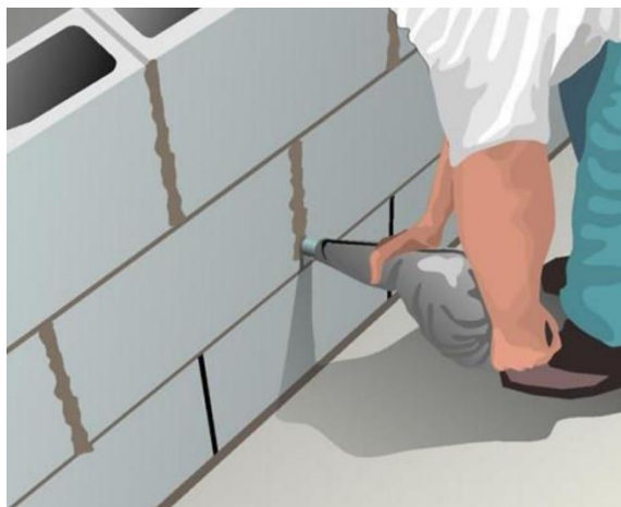
Figura 28 - Bisnaga para aplicação de argamassa nas juntas laterais. Fonte: ABCP.
