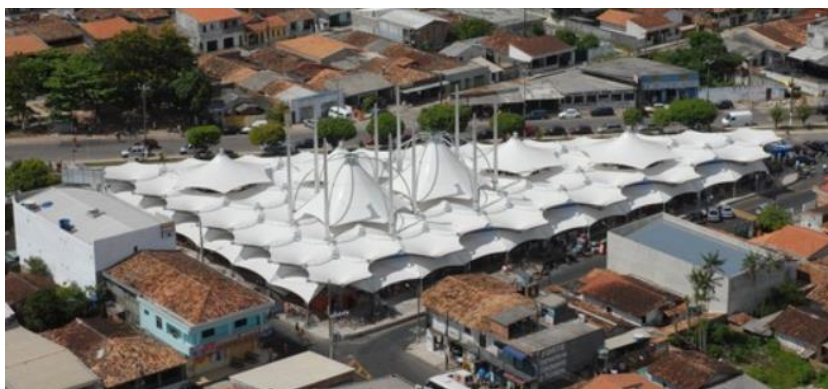
Figura 24 – A tensoestrutura no contexto do entorno.
