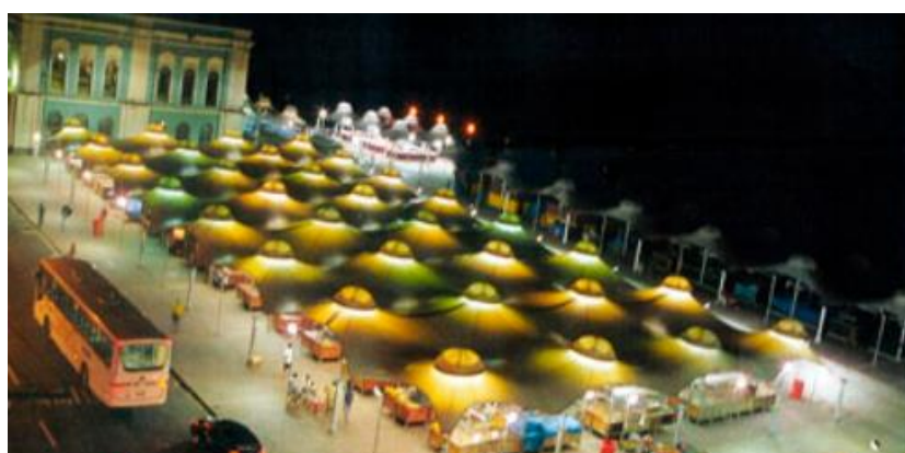
Figura 13– Estrutura da feira do Ver-o-Peso após a intervenção.
