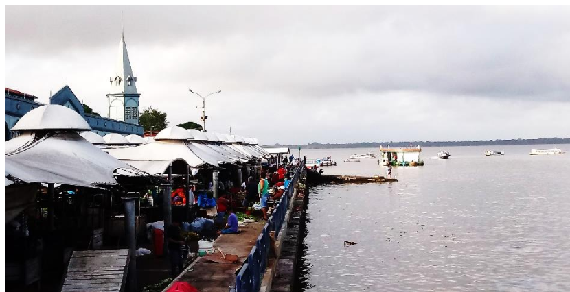
Figura 14 – Organização interna e rampa.
