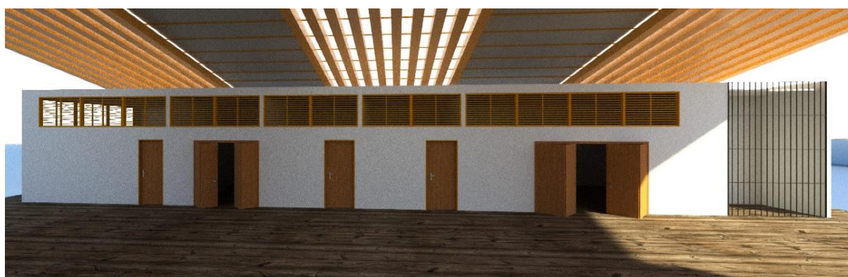
Figura 126 - Esquadrias em madeira
