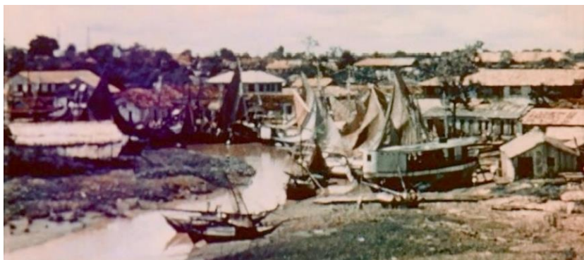
Figura 50 – Canal da Doca da Fortaleza.
