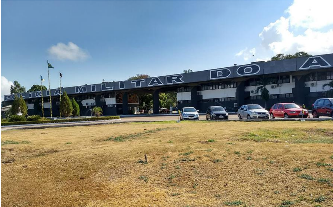
Figura 6: o prédio da Polícia Militar é hoje a obra em melhor estado de conservação.
