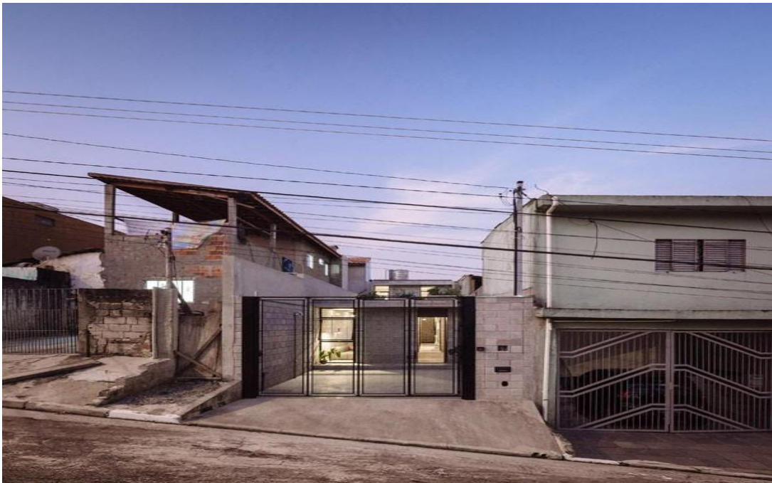
Figura 23: vista frontal da Casa da Vila Matilde.
