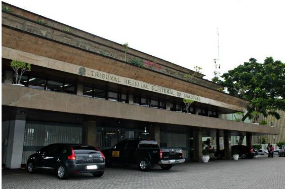
Figura 124: Fachada principal da Sede do TRE – AM
