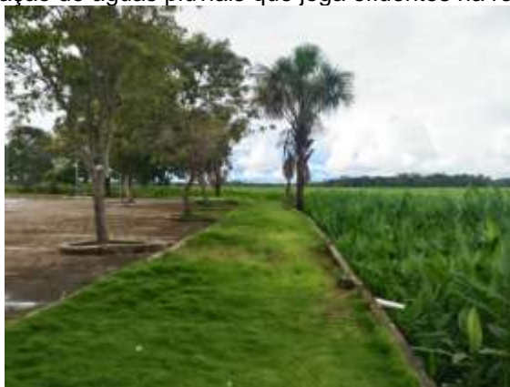
Figura 52 – Tubulação de águas pluviais que joga efluentes na ressaca da Lagoa dos Índios
