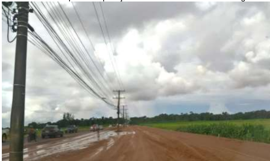
Figura 5 – Aterramento para a duplicação da Rodovia Duca Serra na Lagoa dos Índios
