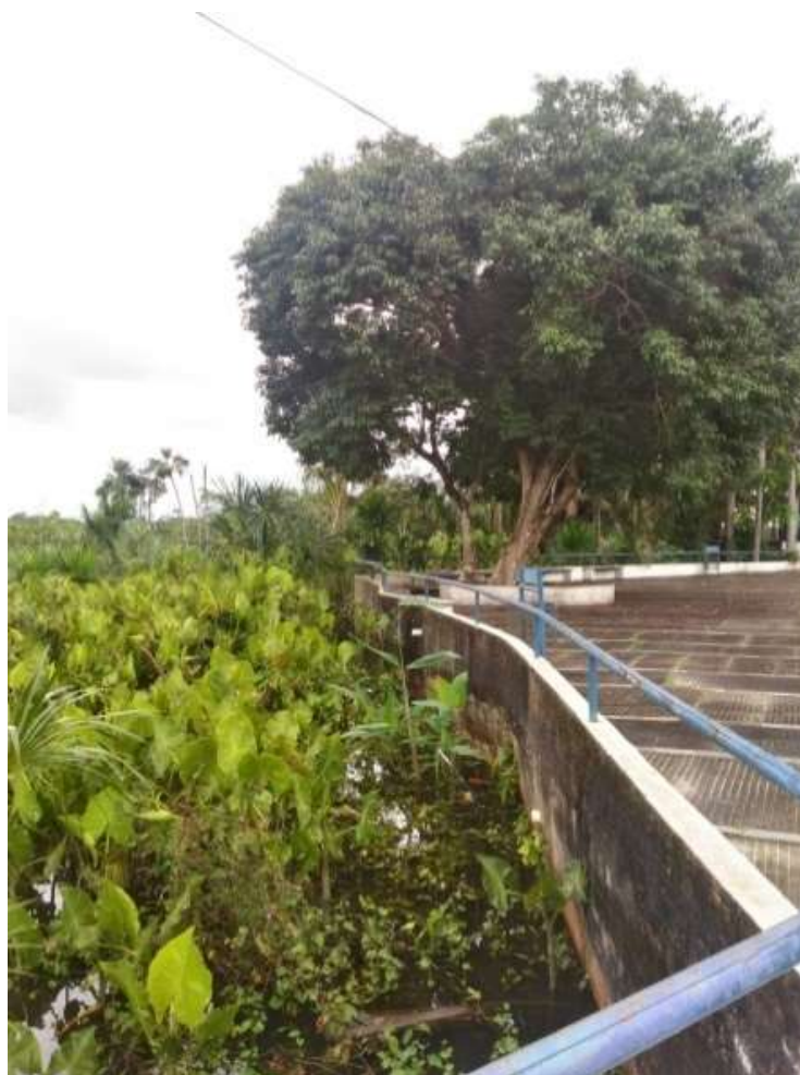
Figura 42 – Tubulações e vegetação filtrante no limite da Lagoa dos Índios com a FAMA
