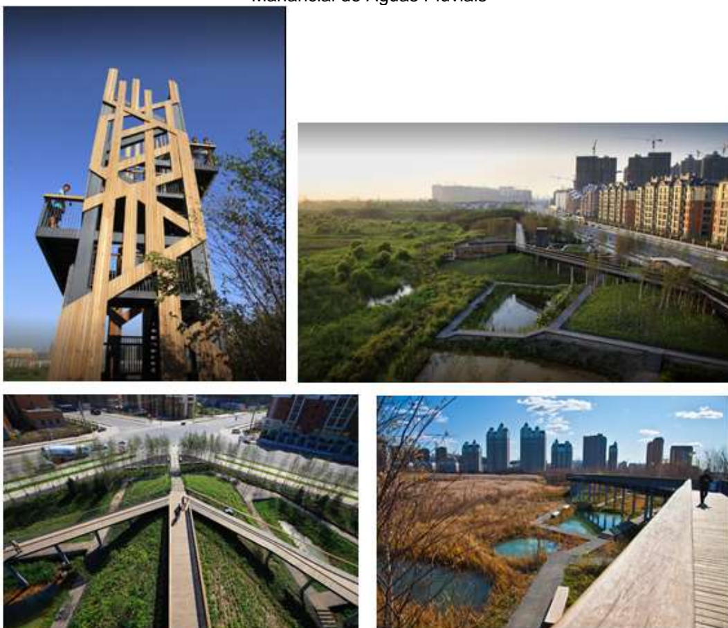
Figura 19 – Mirante, piscinas de acumulação de águas, passarelas e paisagem urbana do Parque Manancial de Águas Pluviais
