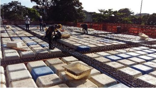
**Laje nervurada protendida com fôrma plástica:** Este tipo de estrutura tem diversas vantagens com relação às estruturas convencionais, a mesma tem peso reduzido em comparação a outras, aumenta os vãos, possui variadas opções de dimensões.
