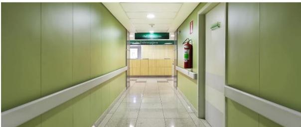
**O Formiwall da Formica:** É o laminado decorativo de alta pressão desenvolvido especialmente para o revestimento de paredes. Garante praticidade, podendo ser aplicado diretamente sobre azulejos, concretos etc.
