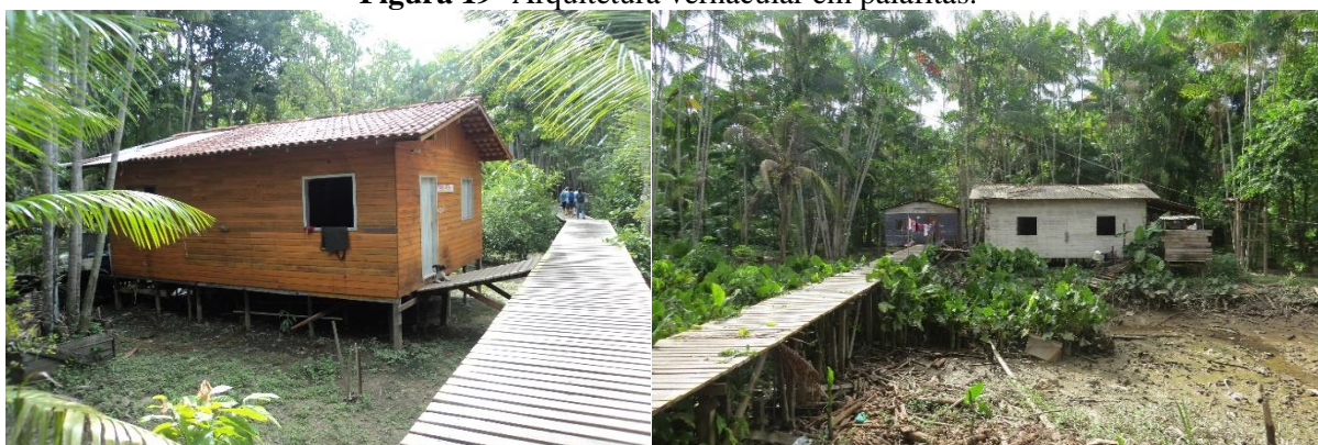
Figura 19- Arquitetura vernacular em palafitas.
