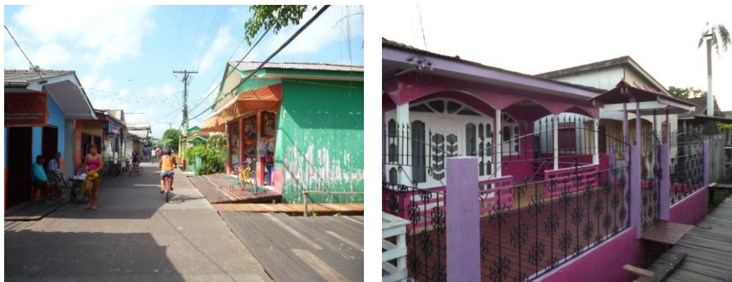
Figuras 5 e 6: Edificações em Afuá
