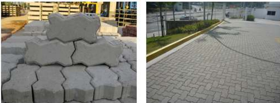
Figura 79: Blocos que compõe o piso Inter travado e exemplo de um piso Inter travado Fonte: http://www.rhinopisos.com.br
