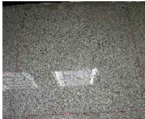
Figura 73: Piso Korodur polido
