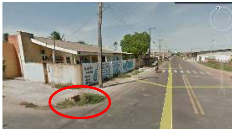
Figura 55: Galeria de águas pluviais na esquina da Avenida 29 de julho, próximo do lote em estudo. Fonte: Google Earth
