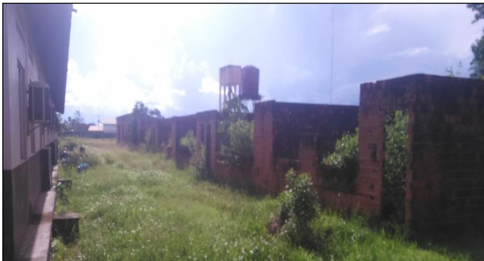
Fig. 75: Instalações e estruturas da AIFA – construção abandonada Fonte: Acervo da autora (2016)
