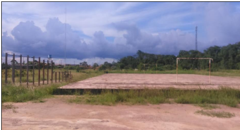
Fig. 72: Instalações e estruturas da AIFA - Quadra Fonte: Acervo da autora (2016)
