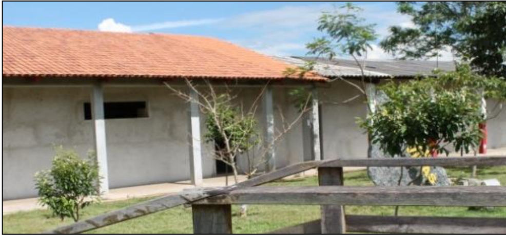
Fig. 10: Alojamento de praças Fonte: CAEBMGO (2015) Disponível em: http://abmgo.com/estrutura
