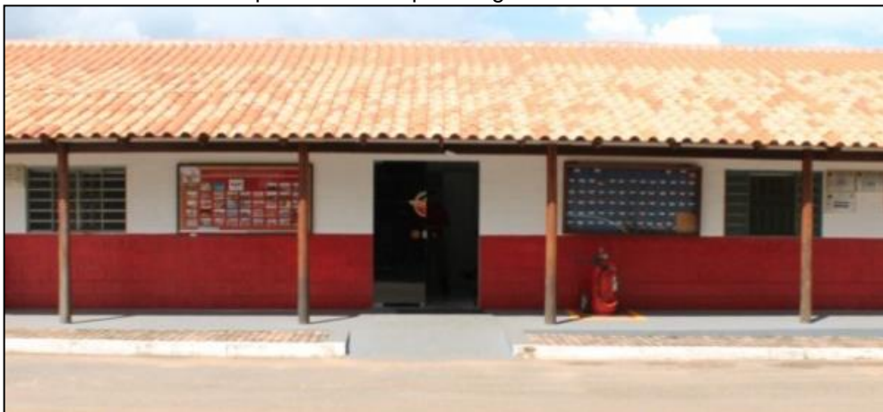
Fig. 5: Sala do Comando CAEBMGO Fonte: CAEBMGO (2015). Disponível em: http://abmgo.com/estrutura
