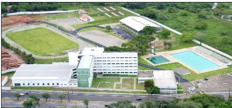
Fig. 18: Vista aérea da AESP.
