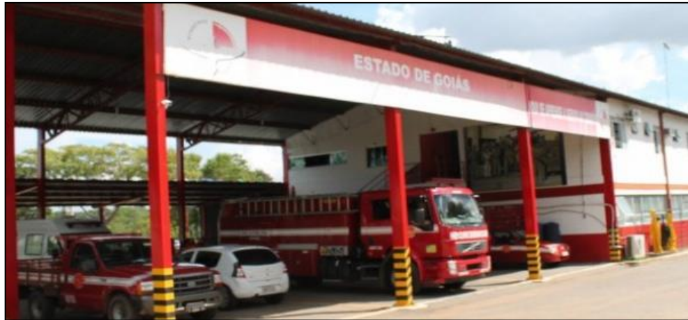
Fig. 15: Garagem CAEBMGO Fonte: CAEBMGO (2015)
