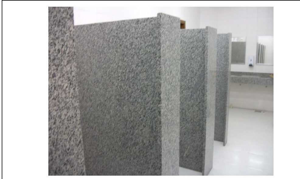
Fig. 88: Exemplo da utilização do mármore para divisórias de cabines em banheiro. Fonte: http://www.artepedras.yolasite.com/lavabos-e-banheiros.php
