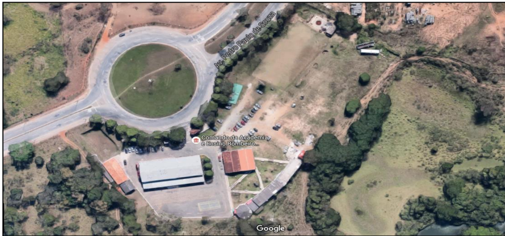
Fig. 3: Vista aérea da CAEBMGO Fonte: Google Earth (2016).
