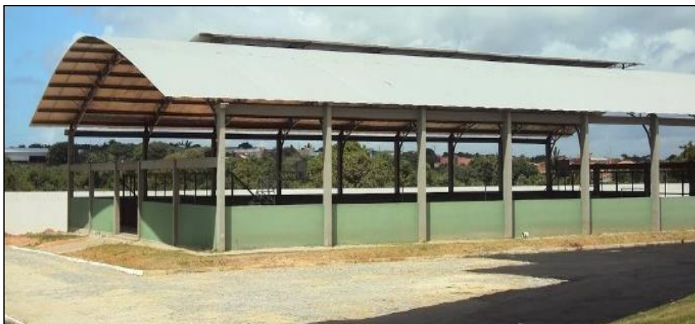
Fig. 21: Ginásio Poliesportivo AESP. Fonte: AESP CE (2011). Disponível em: http://www.aesp.ce.gov.br
