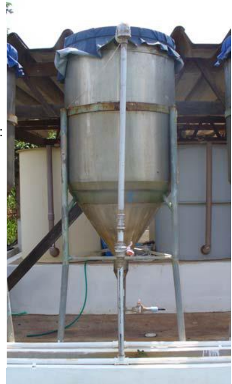
Figura 25: Modelo cilíndrico do filtro de tratamento de esgoto. Fonte: TONETTI, 2008
