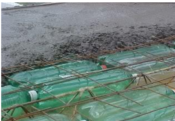
Figura 37: Concreto sobre as garrafas PET
