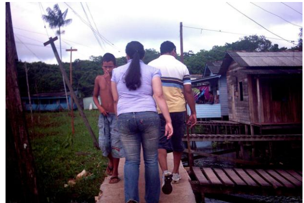
Figura 33: Passarela sem Guarda-corpo.
