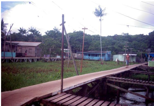
Figura 32: Passarela sobreposta à antiga.
