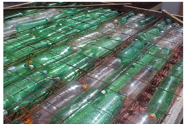
Figura 38: Disposição das garrafas PET
