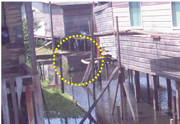
Figura 16: Lançamento dos dejetos não tratado. Fonte: FERREIRA, Derlani. Dez. 2009.
