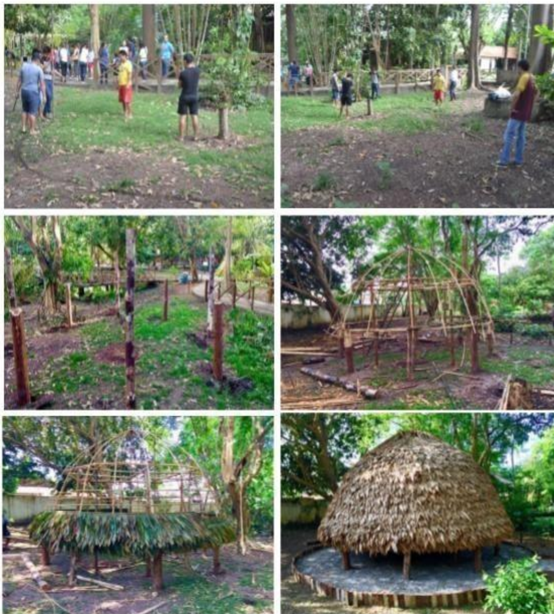
Figura 5 - Construção da Casa Indígena Wayana Aparai.
