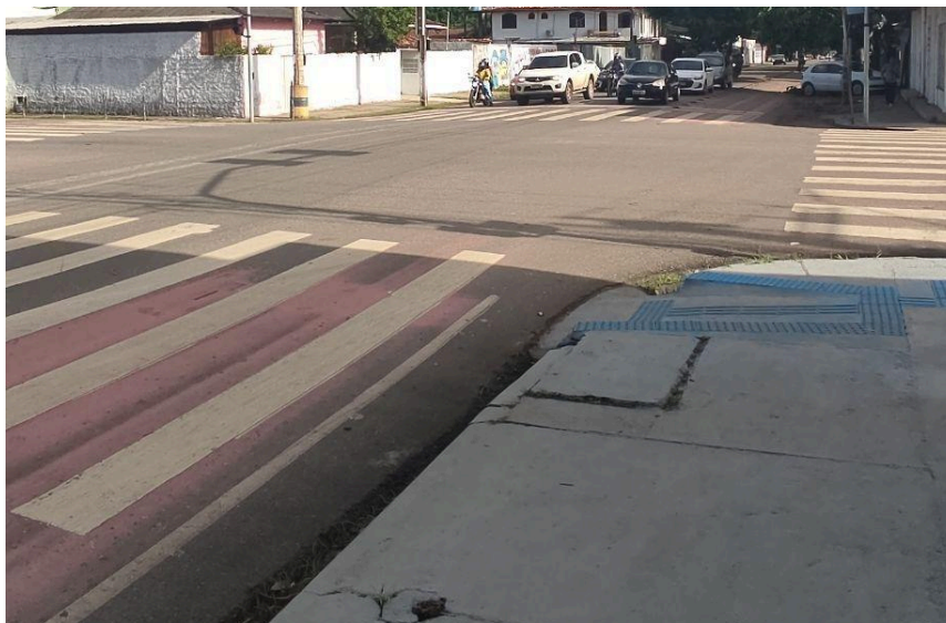
Figura 4: Não há marcação de cruzamento rodocicloviário.
