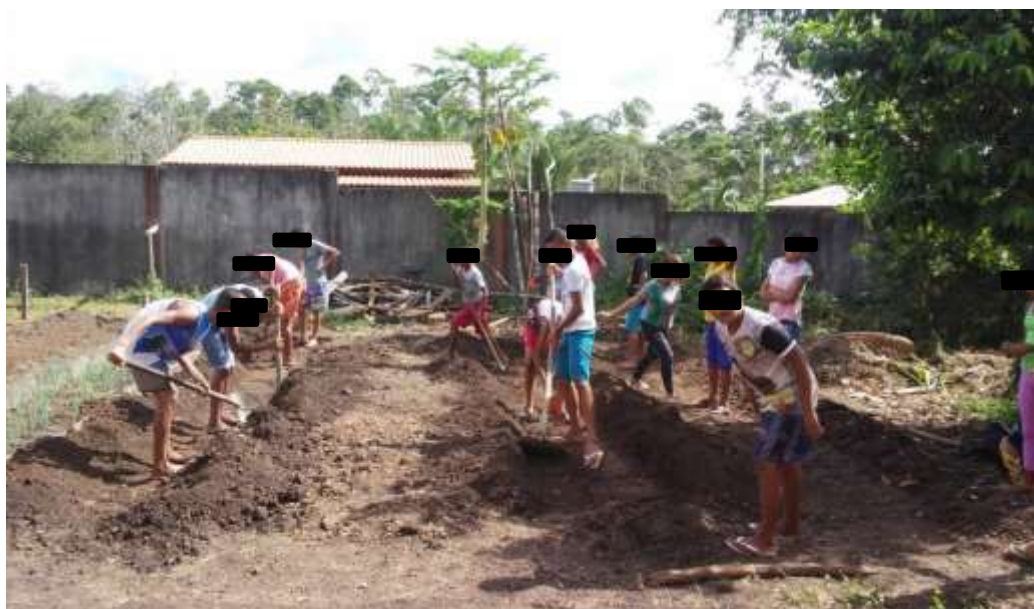
Fotografia 5 - Construção dos canteiros. Mazagão – AP, 2019.
