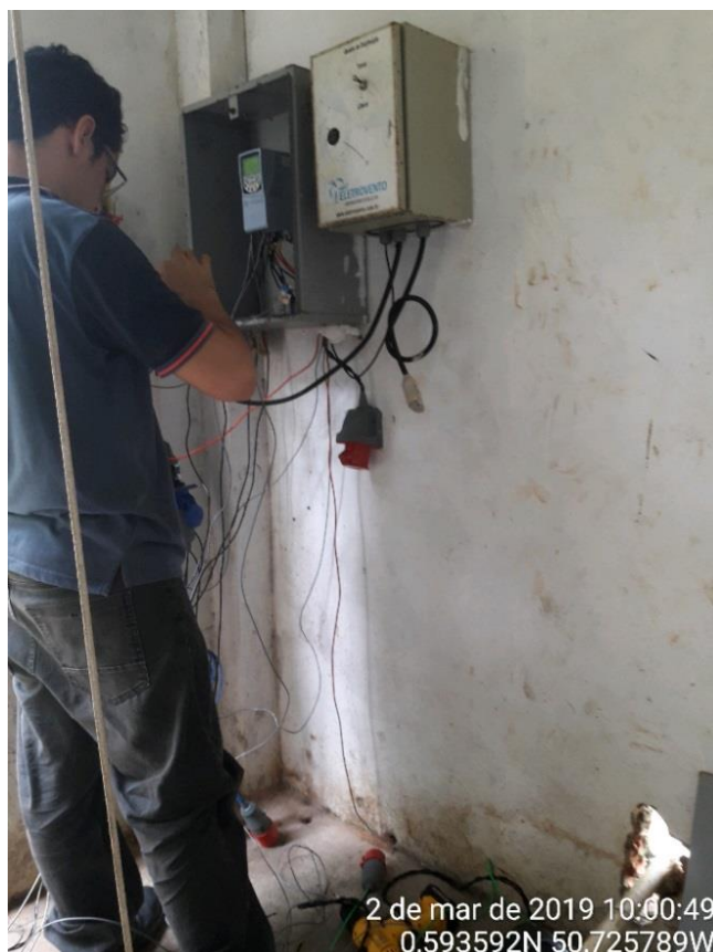
Figura 32 – Inspeção final no quadro da unidade de condicionamento de potência.
