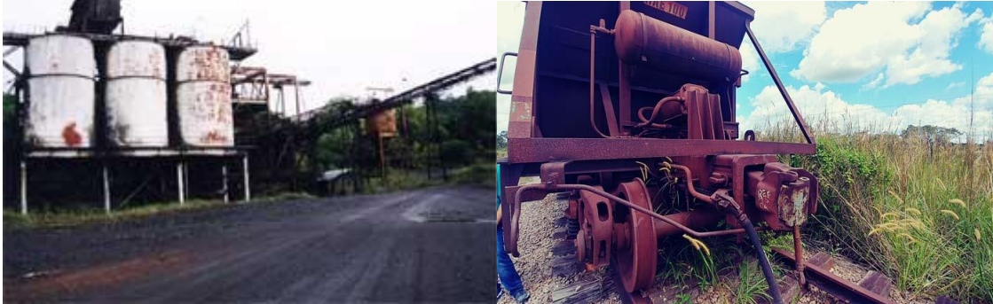
Figura 2: Maquinário de mineração e transporte de minério, heranças da ICOMI, abandonados.
