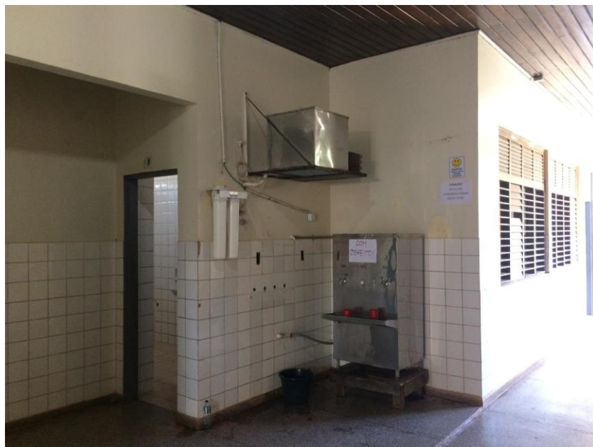
Figura 2 – Corredor dos banheiros.
