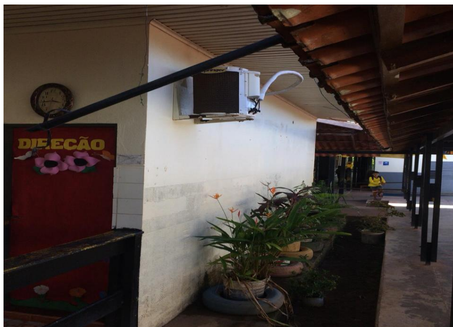
Figura 3 – Corredor da sala da direção e da coordenação.
