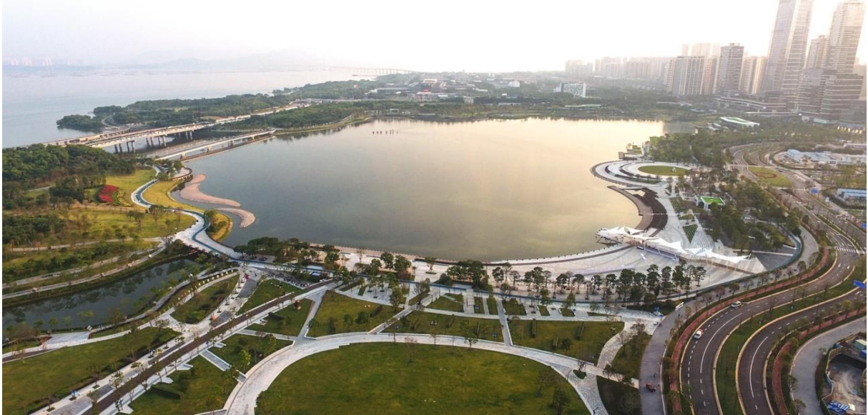
Figura 1 - Vista geral do Parque Shenzhen Talent
