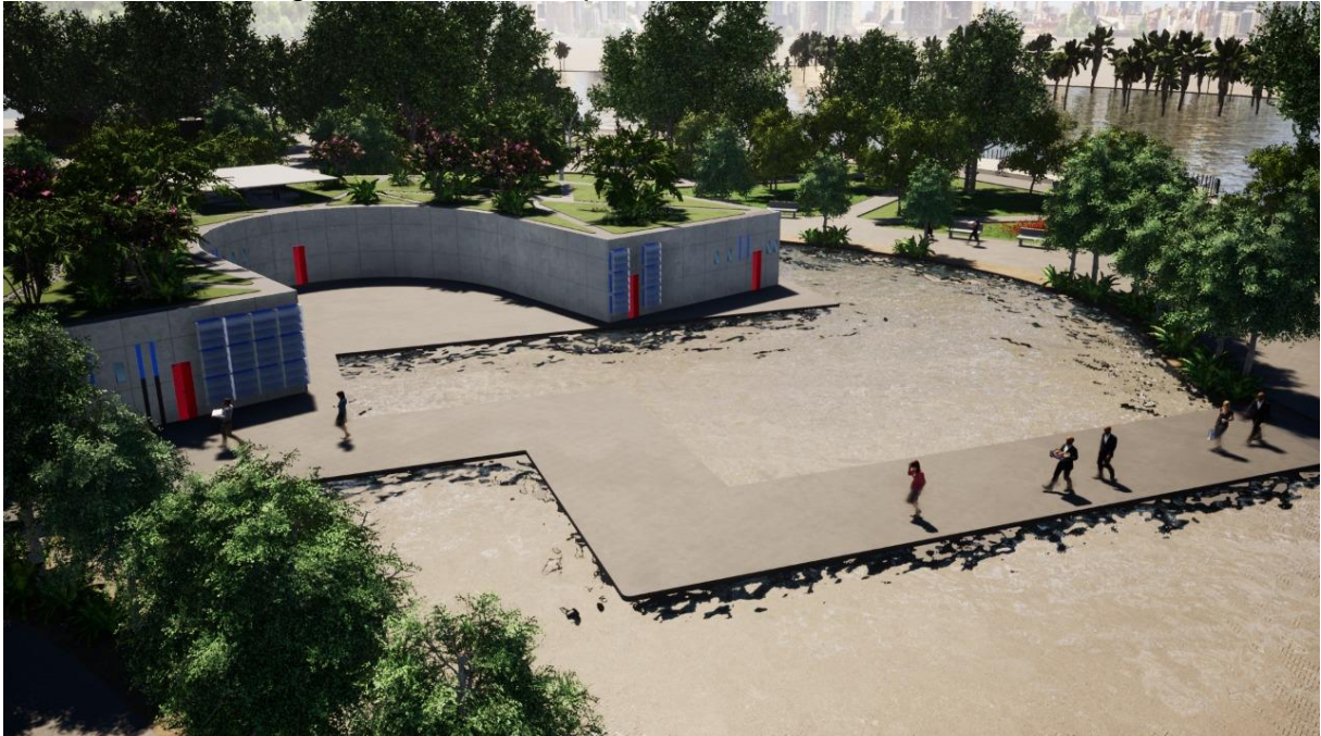
Figura 55 - Fachada posterior do Centro de Eventos
