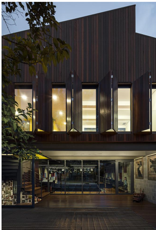
Figura 11: Visão da fachada com utilização de brises para iluminação natural
