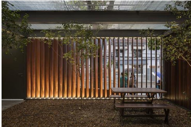
Figura 12: Brises verticais de madeira para integração de ambientes
