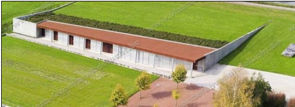
Figura 1– Vista aérea do edifício do cemitério de Kortrijk.
