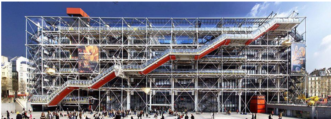
Figura 9 – Fachada principal do edifício Pompidou que possui espaço para várias atividades culturais.
