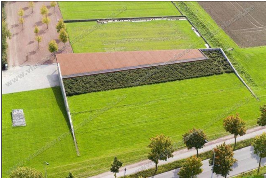
Figura 3– Vista aérea do edifício do cemitério de Kortrijk
