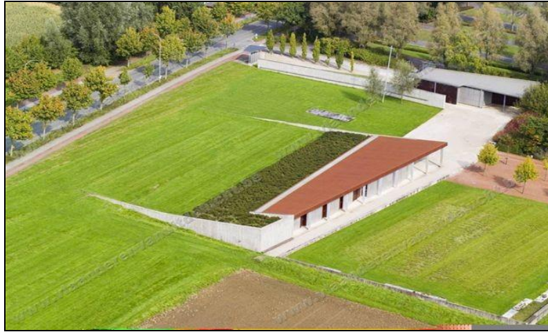
Figura 2 – Vista aérea do edifício do cemitério de Kortrijk
