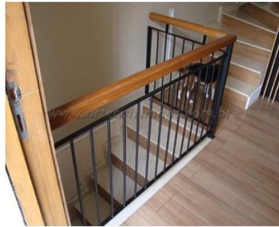
Figura 69 – Modelo de guarda-corpo em aço.
