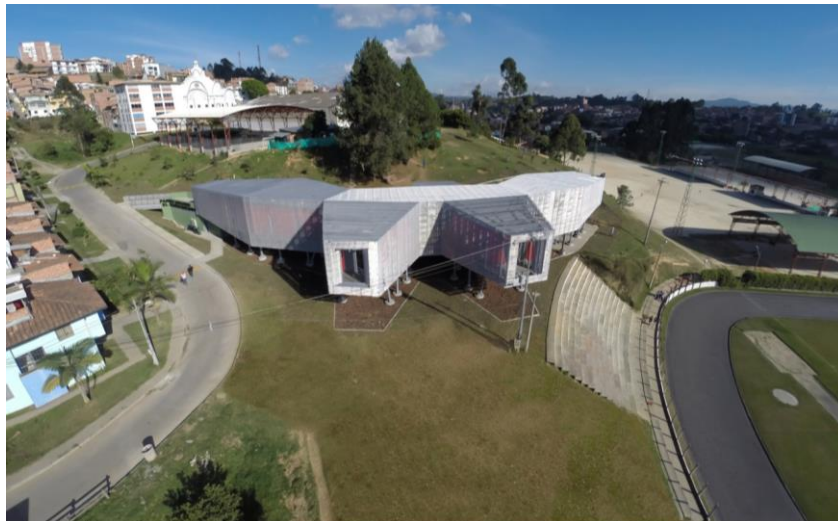
Figura 10 – Edifício do Parque Educativo de Manirilla.
