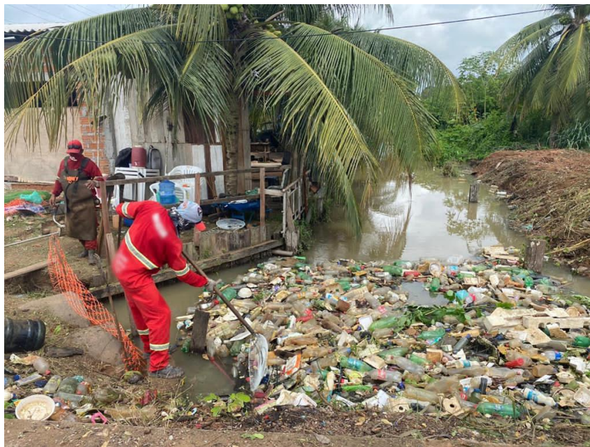
Figura 4 – Desobstrução dos canais de macrodrenagem em Macapá (PMM, 2020).
