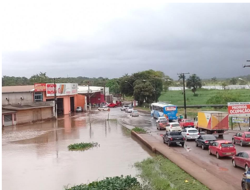
Figura 3 – Exemplo de alagamento no núcleo urbano de Macapá (Arquivo Pessoal, 2019).
